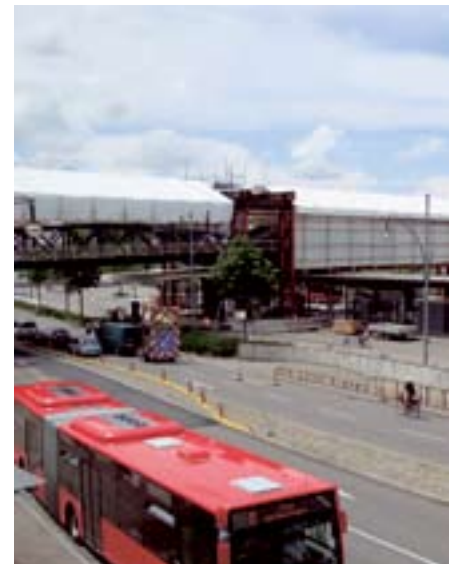
Eine Generalsanierung erfuhr die Brücke insgesamt 6,3 Millionen Euro wurden da
