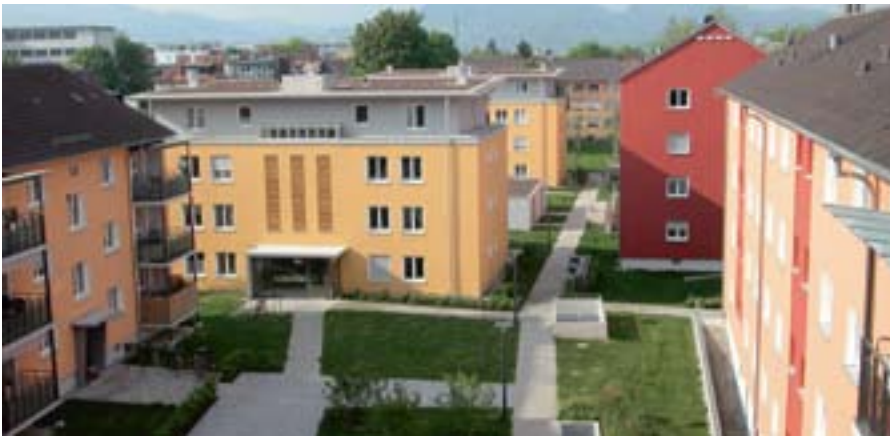
Modernes Gesicht und vorbildliche Energiebilanz: die sanierten Gebäude bringen einmal mehr Farbe in den Stühlinger. Text und Bild: Freiburger Stadtbau
