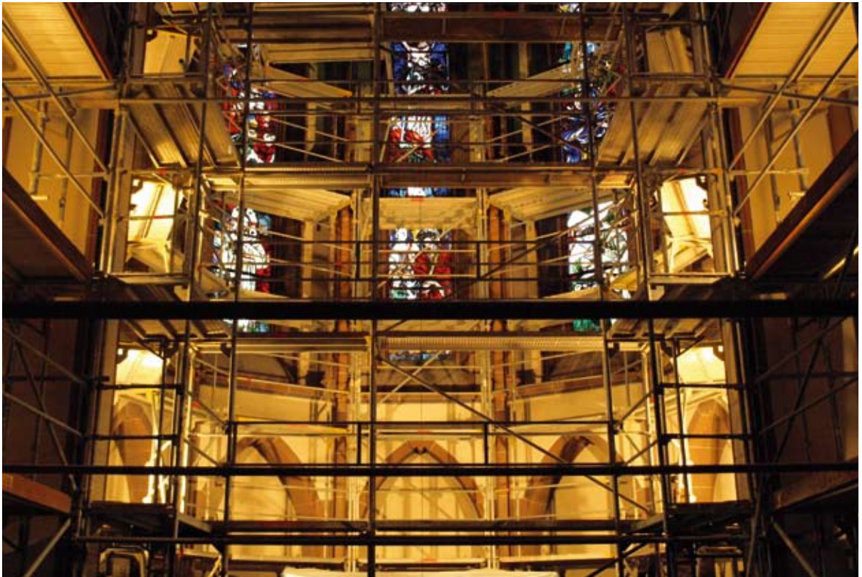
Eingerüstet bis unter das Dach war der Innenraum der Herz-Jesu-Kirche während der Renovierung.
